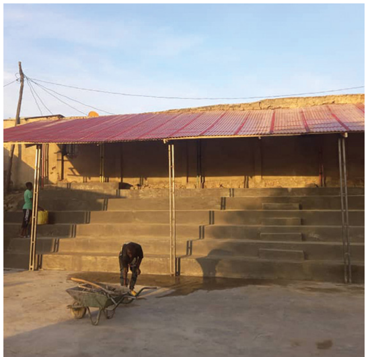
Der Innenplatz und die Sitzarena müssen nur noch gestrichen werden. The indoor court and the seating arena just need to be painted.
