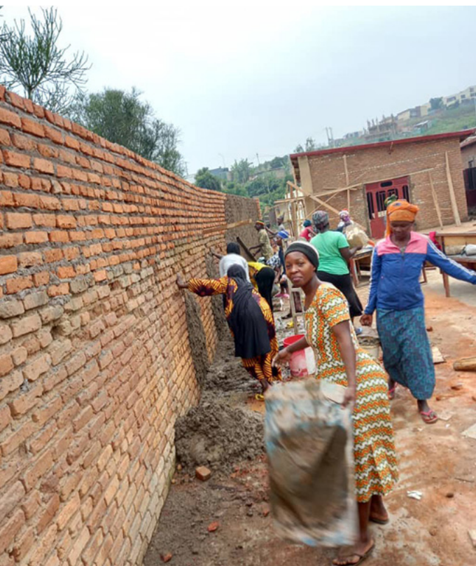
Mütter und Väter helfen beim Bau. Mothers and fathers help with the construction.
