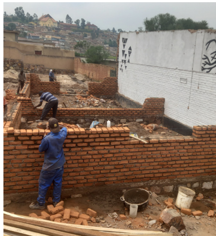
Die ersten Wände der Klassenräume stehen. The first walls of the classrooms are up.
