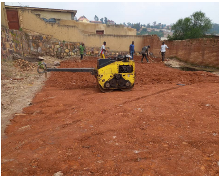
Die Vorbereitungen für den Bau der Klassenzimmer laufen. Preparations for the construction of the classrooms are underway.
